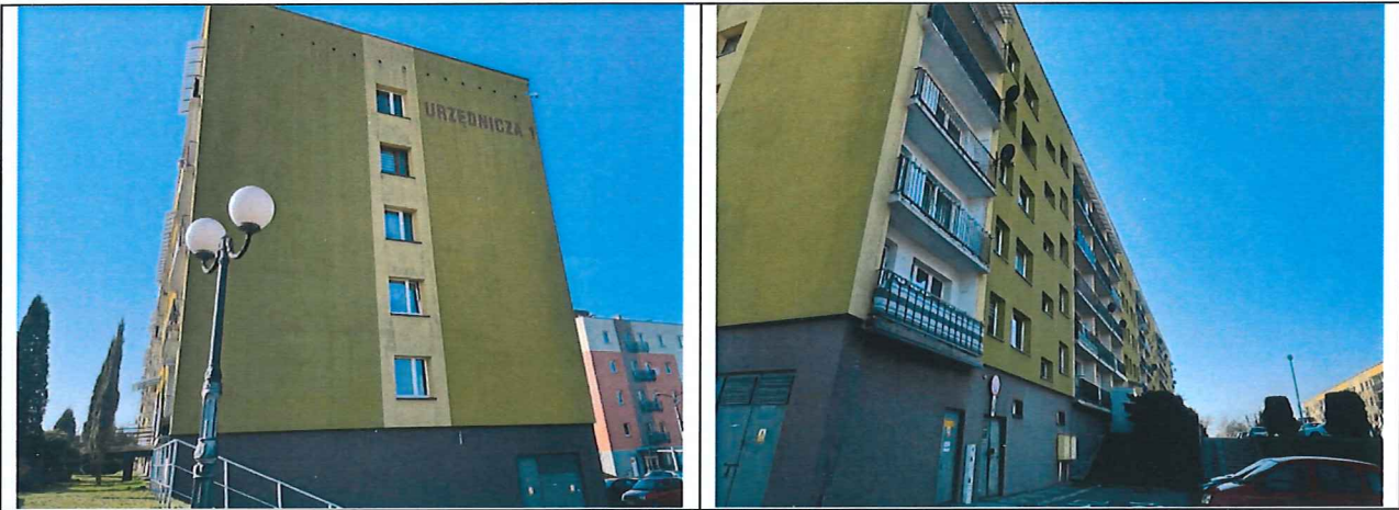
ogólny widok budynku
